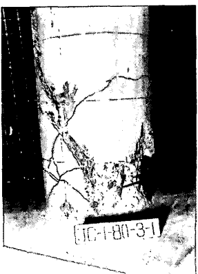
写真—3 最終破壊状況（破壊形式：S，試験体 No. 9）
