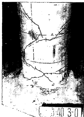
写真—1 最終破壊状況（破壊形式：F，試験体 No. 15）
