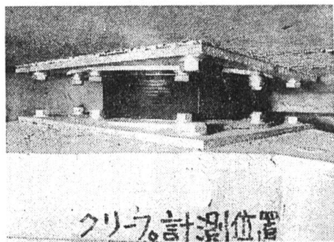
クリフ。計測位置 215°の家屋を支える積層ゴム
