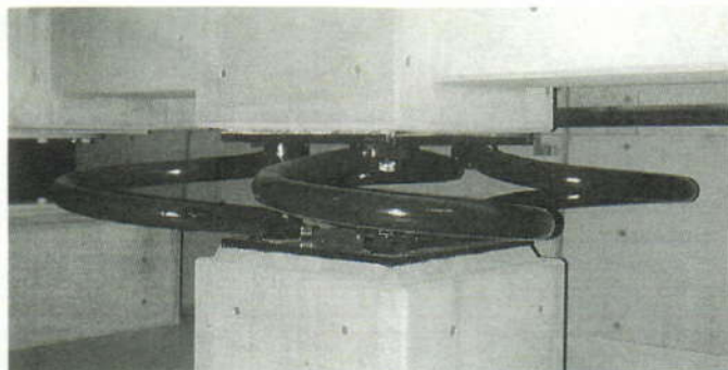
免震層に働く力を減少させるダンパー
