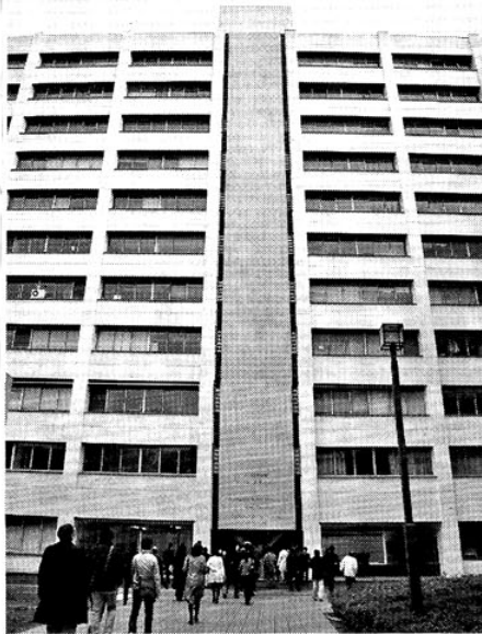
中央部分に設置されたロッキング耐震壁
